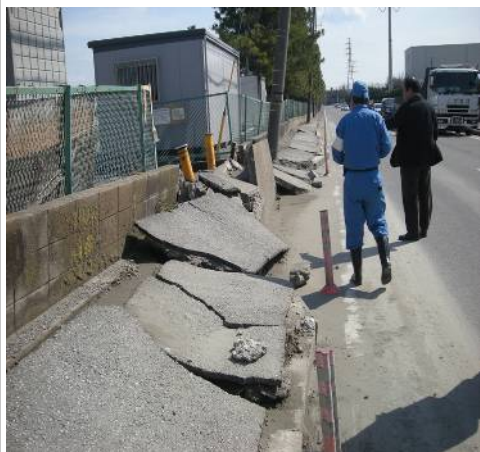
東日本大震災では、船橋市内海浜部で液状化による被害（写真上）、北部では屋根瓦損壊がありました。（写真下）
